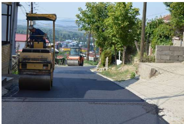
Асфалтирање на ул. Владимир Назор
