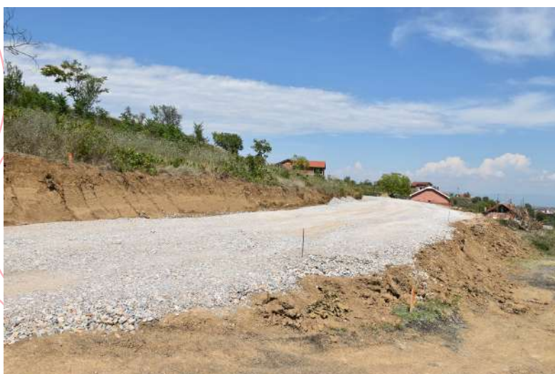
Пробивање и асфалтирање на ул. Црноречка
