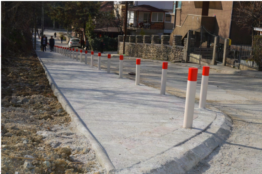
Поплочување на тротоар на ул. Рајко Жинзифов
