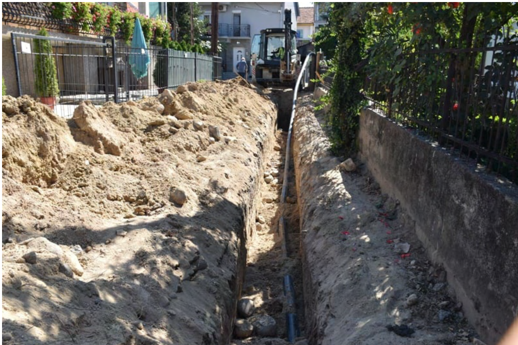
Реконструкција на водовод и канализација на ул. Даме Груев
