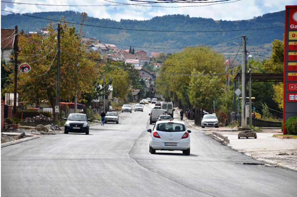
Асфалтирање на ул. Шишка
