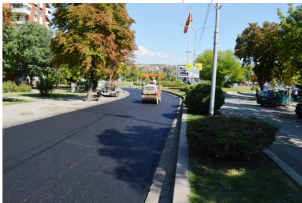
Асфалтирање на ул. Моша Пијаде
