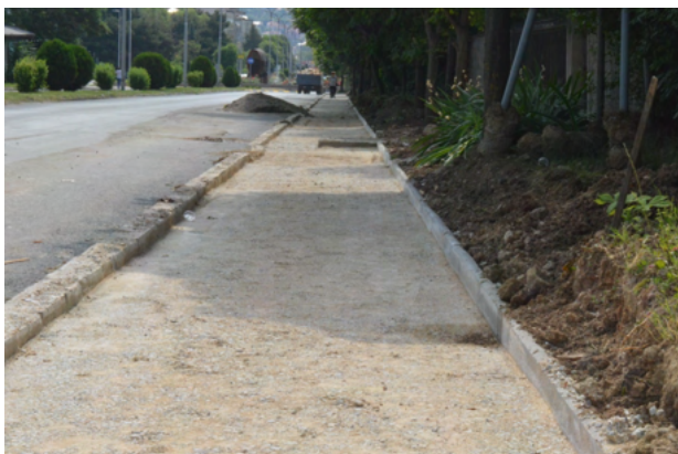
Поплочување на тротоар на ул. Моша Пијаде
