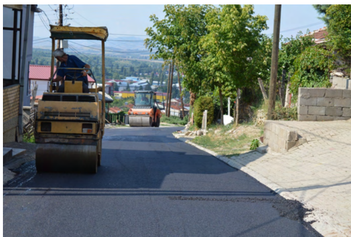
Асфалтирање на ул. Владимир Назор
