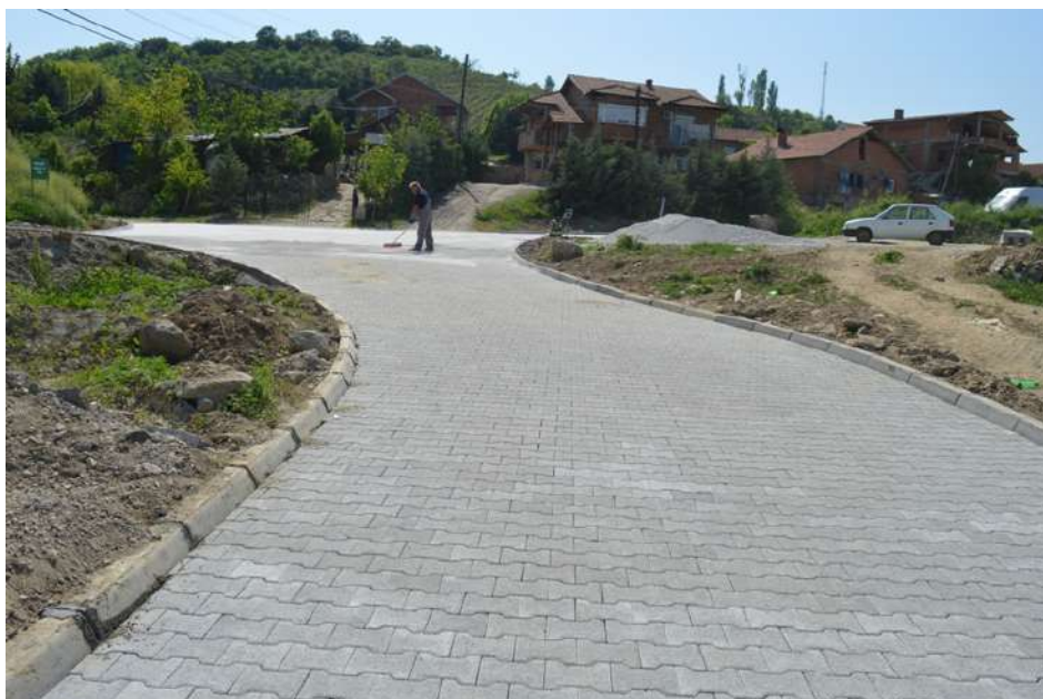
Поплочување на ул. 12 дугари
