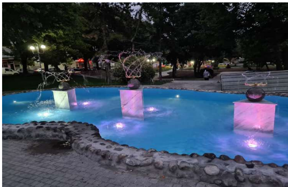
Реконструкција на фонтаната во паркот на револуцијата
