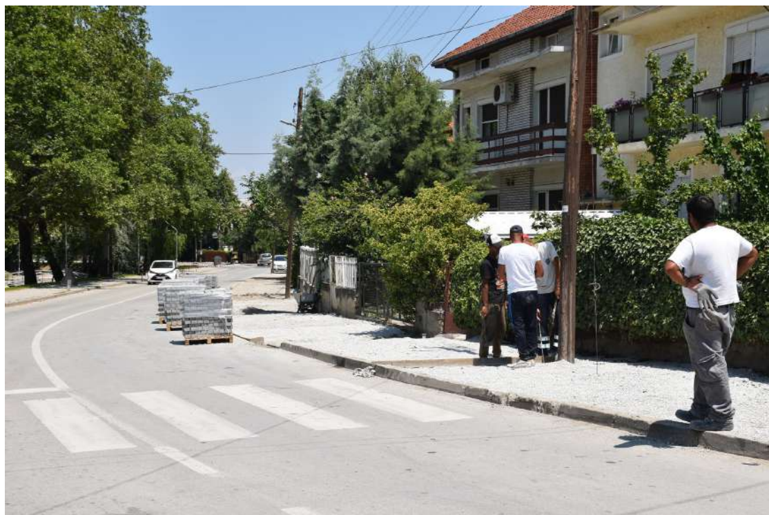
Поплочување на тротоар на ул. Киро Крстев
