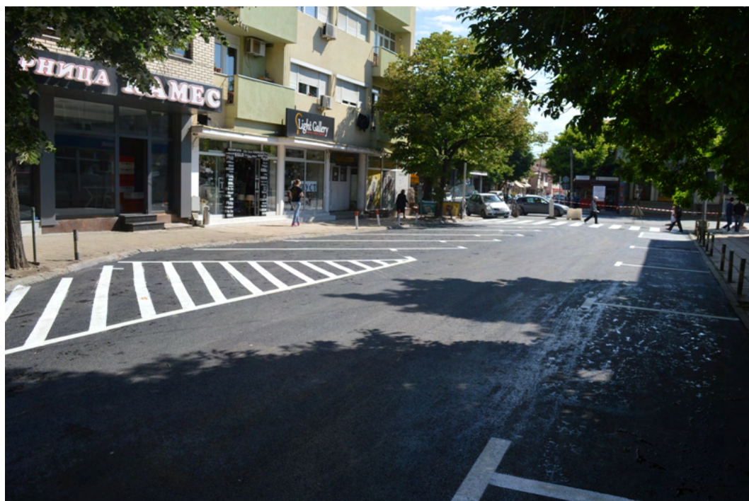
Реконструкција на ул. Пано Мударов и поставување на нови метални столбови
