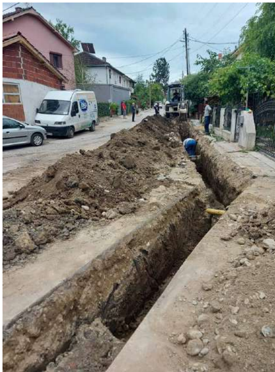
Реконструкција на водоводна и канализациона мрежа на ул. Стив Наумов
