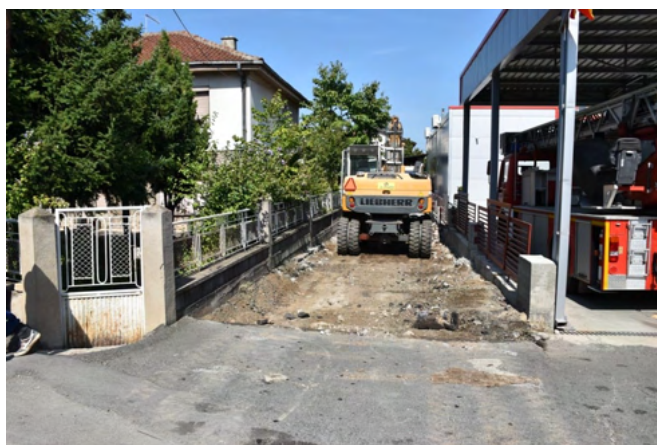
Бетонирање на улочка на Пожарната станица
