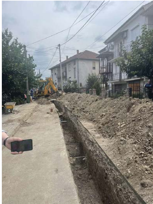
Нова водоводна линија на ул. 41 Дивизија и дел од ул. Црноречка
