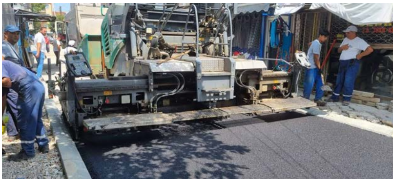
Асфалтирање на ул. Зелен Пазар
