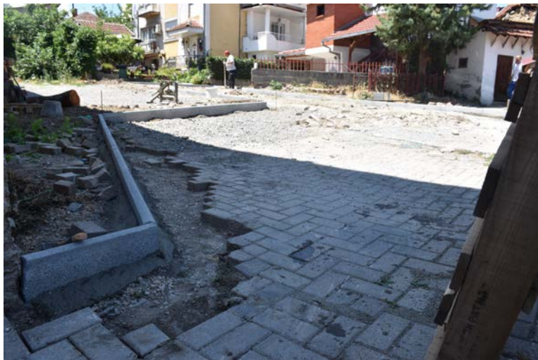
Поплочување на крак од ул. Браќа Хаџи Тефови
