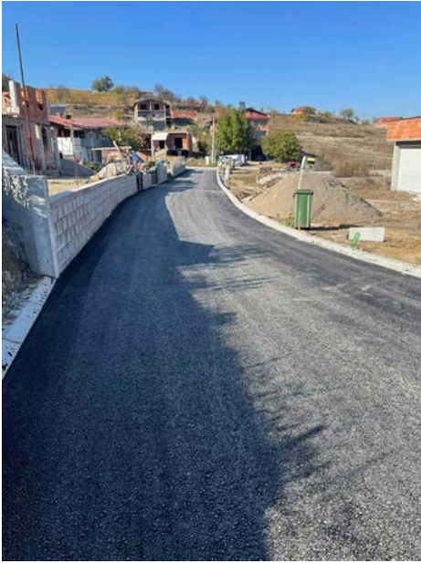
Асфалтирање на ул. Наца Пинџурова
