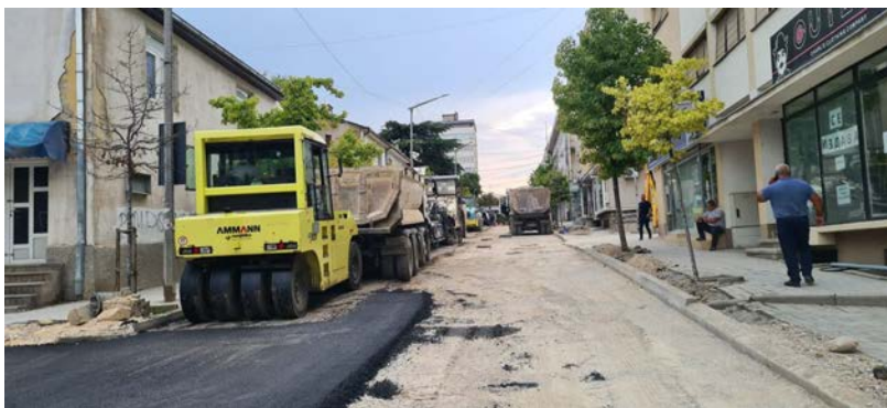
Асфалтирање на ул. 7ми Септември
