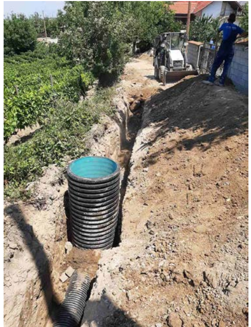
Реконструкција на фекална канализација на ул. Фуштани
