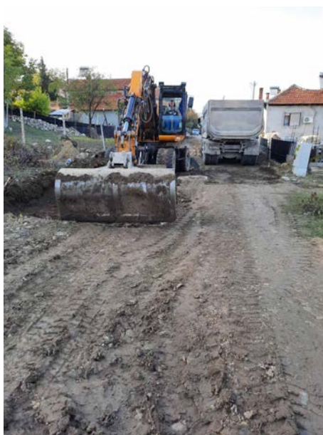
Асфалтирање на ул. Моклишка
