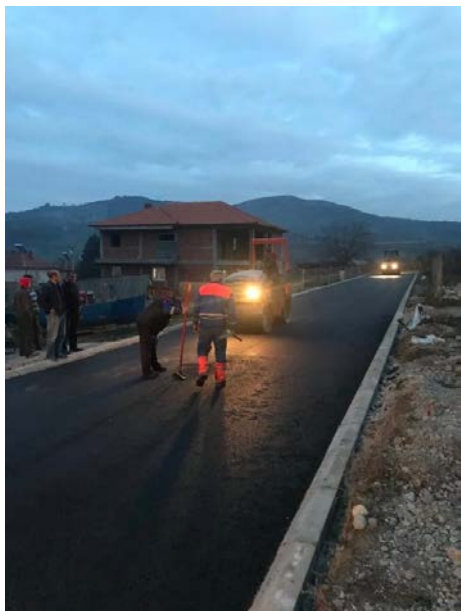
Асфалтирање на ул. Моклишка
