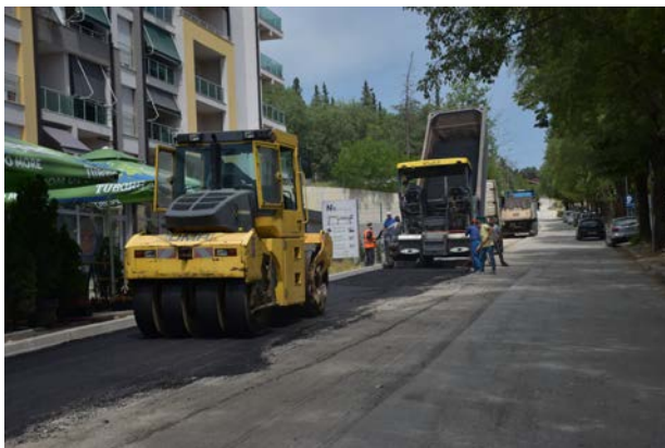
Реконструкција и асфалтирање на ул. Дисанска
