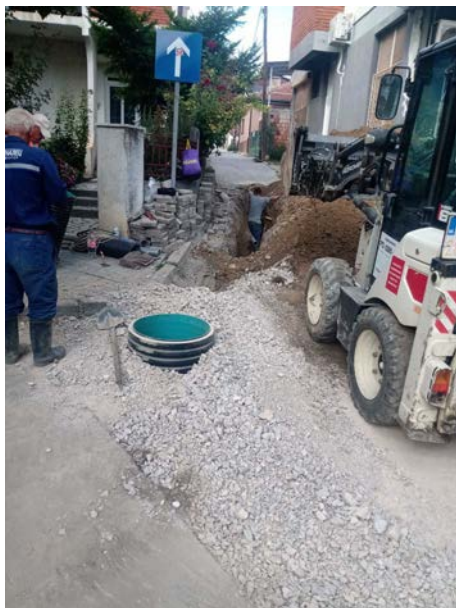
Реконструкција на фекална канализација на ул. Диме Атанасов
