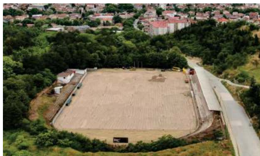
Реконструкција на градскиот фудбалски стадион
