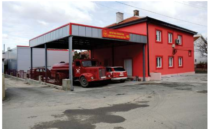
Реконструирана зграда на пожарна Кавадарци
