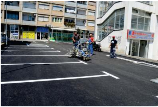
Обележување на хоризонтална сигнализација
