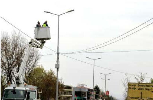
Монтажа на ЛЕД светилки - високи столбови
