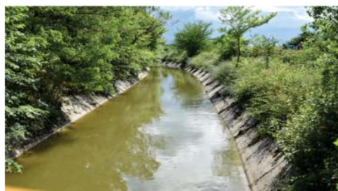
Отворен магистрален канал
