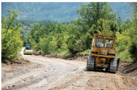
Реконструкција на локален пат Страгово - Крњево
