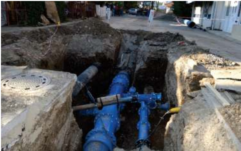
Реконструкција на средна зона голем вентил
